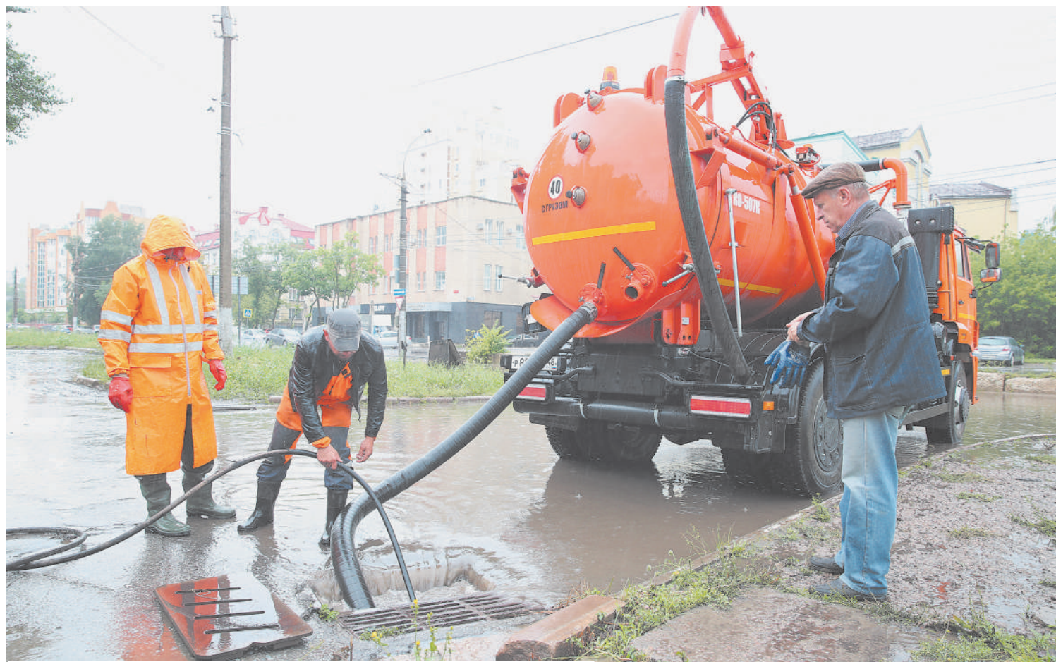
Всю минувшую неделю городские службы работали в режиме повышенной готовности. Сотрудники управления благоустройства очищали дороги, с помощью ассенизаторских машин откачивали воду и прочищали сети ливневой канализации
