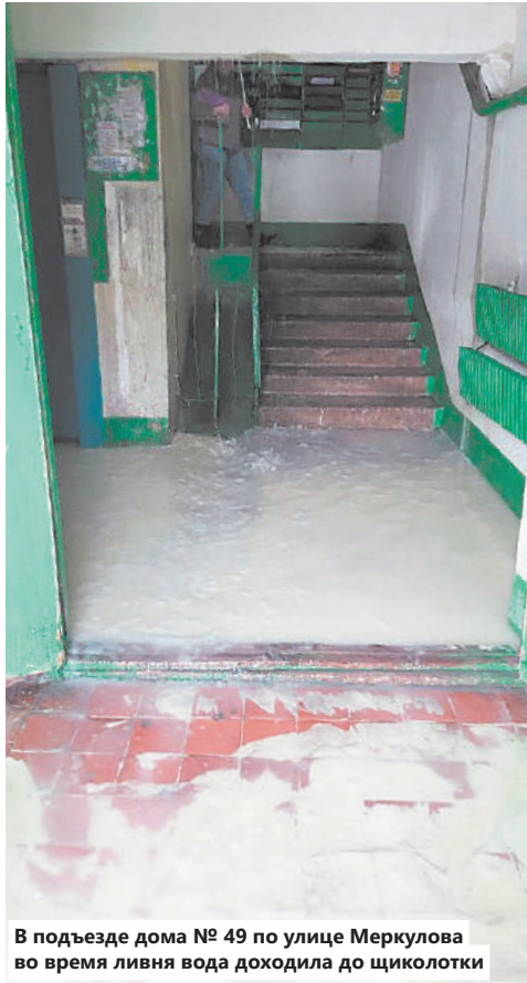
У Андрея Крыкова из 92-й квартиры провис и порвался натяжной потолок, потекли жидкие обои и треснули наличники на дверях. Общий ущерб от залития составил 20 тысяч рублей
