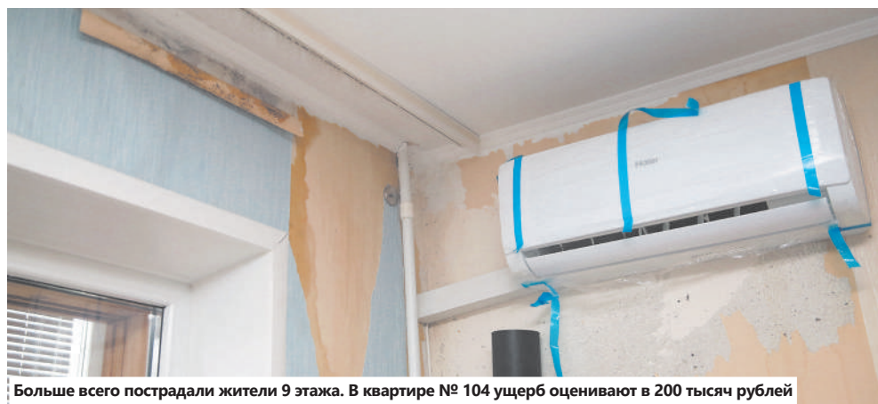
Причиной заливания стала ливнёвка на крыше. Её сорвало мощным потоком воды. Жильцы говорят, что проблемы с текущей крышей в доме с 2018 года
